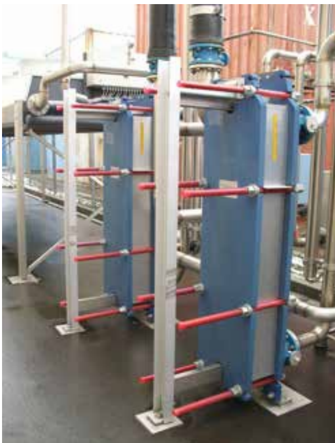
Uitkoppeling van de warmte uit de bio-wkk bij Van Tuijl door middel van warmtewisselaars (foto: Van Tuijl).
